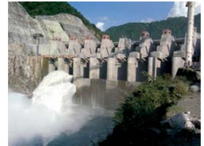
Vishnuprayag Barrage Site
